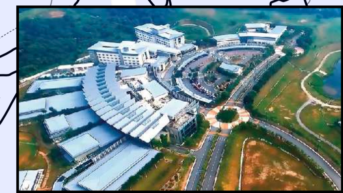
PERKESO - REHABILITATION CENTRE MELALA (マレーシア)
