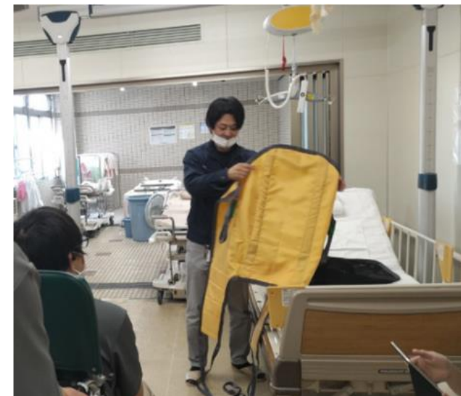
設置した門型リフト 4
